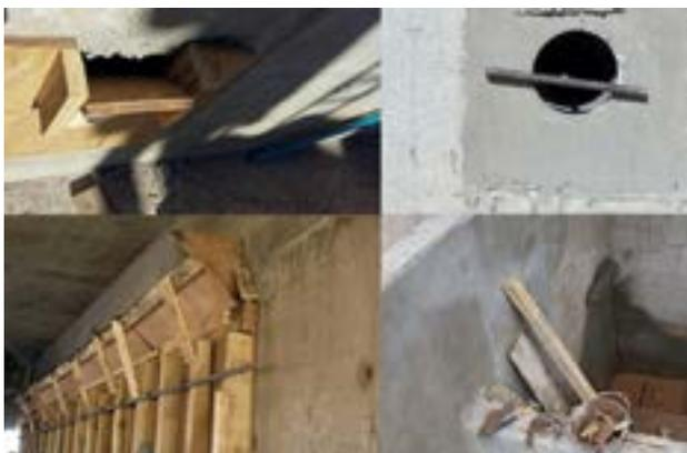
FIGURA 5 - ENCOFRADO Y LLENADO POR GRAVEDAD (GRANDES ESPESORES)
