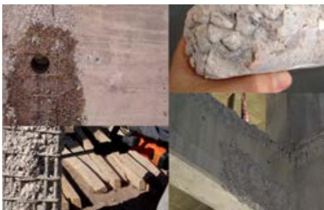
FIGURA 3 - DETERMINACIÓN DE PROFUNDIDAD DE DEFECTOS Y PREPARACIÓN DE SUPERFICIES
