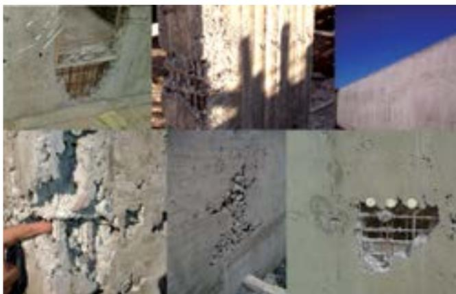
FIGURA 1 - DEFECTOS TÍPICOS DE LLENADO QUE MERECEEN REPARACIÓN
