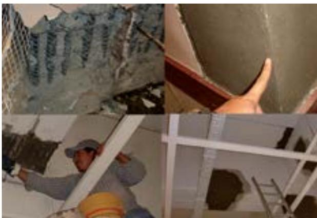
FIGURA 7 - PREPARACIÓN DE SUPERFICIES Y REPARACIÓN EN ESPESORES BAJOS (< 3 CM)
